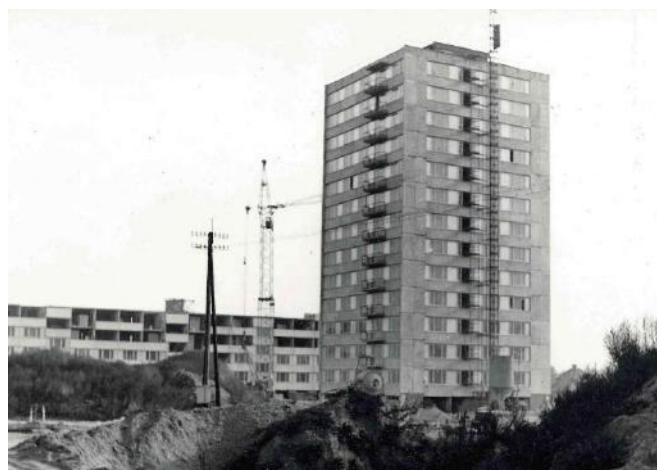
Staveniště okolo věžáku
