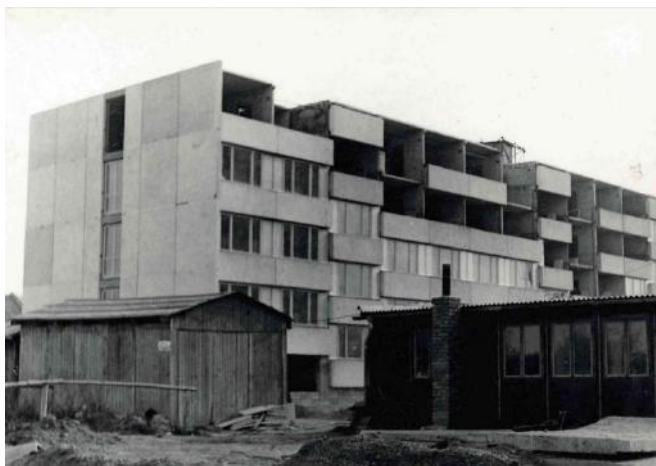
Panelák ve výstavbě. Jsou zde zřetelně vidět panely a meziokenní vložky
