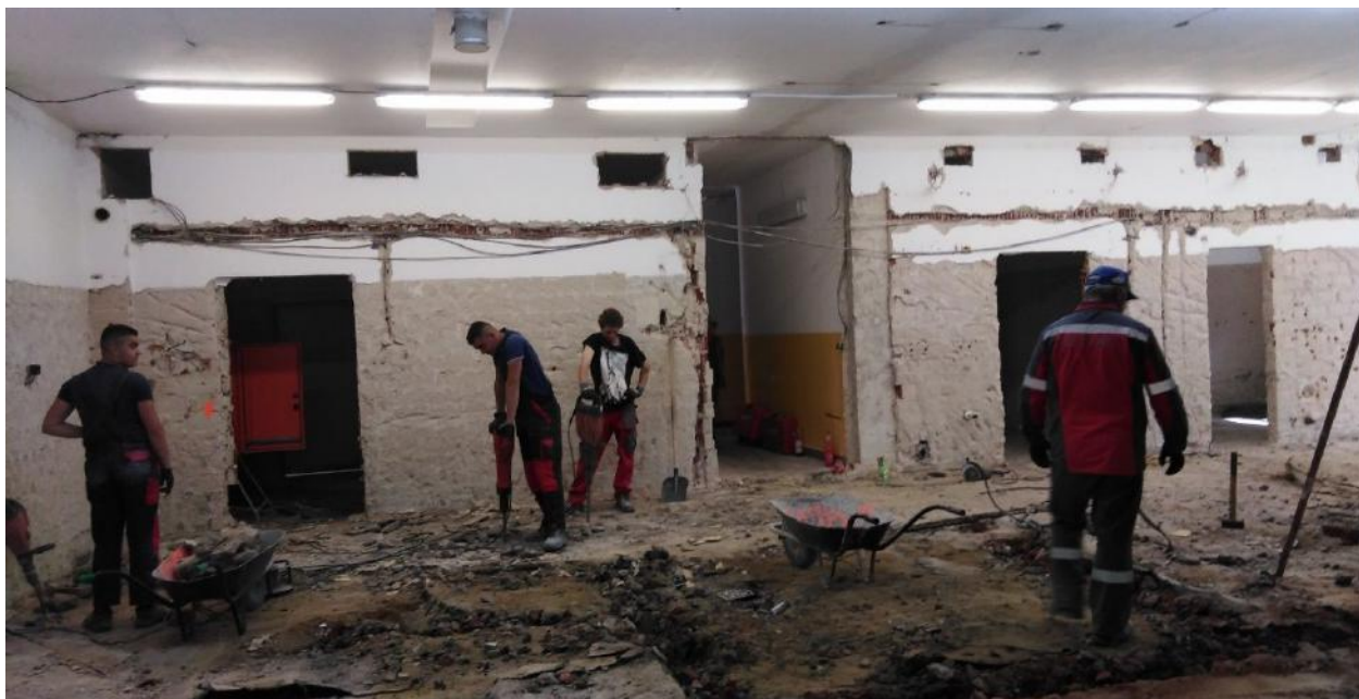
Dělníci rozvrtávají podlahu
