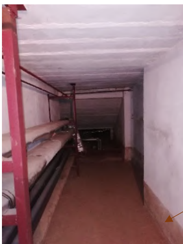
Chodba pod schody u jídelny
