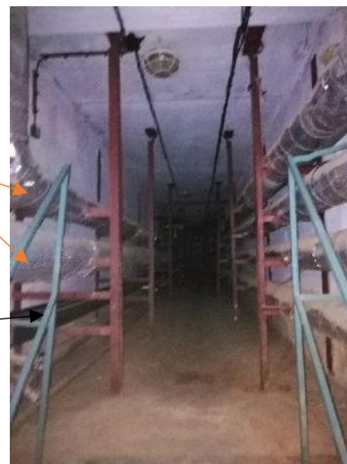
Chodba pod druhým stupněm – vstup
